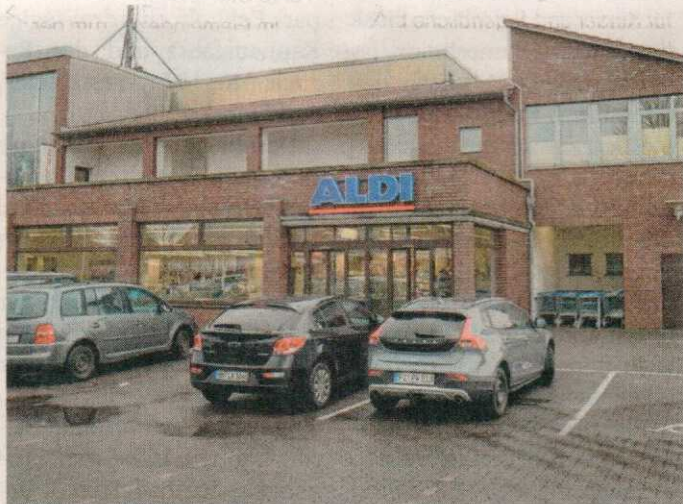
Der Aldi-Markt an der Güttloh: Erweitern möchte das Unternehmen die Ladenfläche nicht, sondern lieber neu bauen. FRANK
